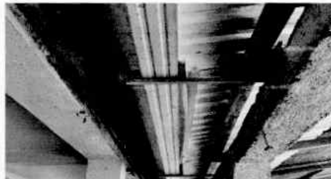
Foto 4: Sustitución de cuneta de concreto por canal de metal
