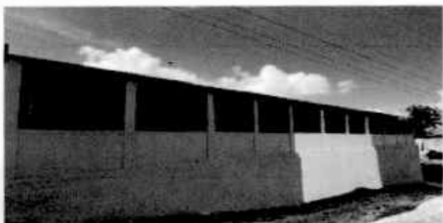
Foto 1: Repello de muros
