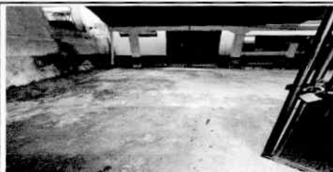
Foto 6: Sustitución de cuneta de concreto.
