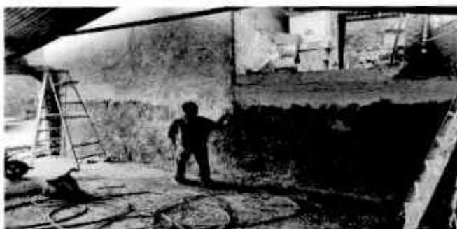
Foto 5: Repello de muro
