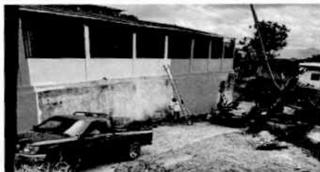
Foto 1: Repello de muros
