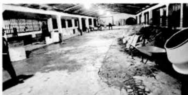
Foto 3: Reparación de plancha de concreto de patio.
