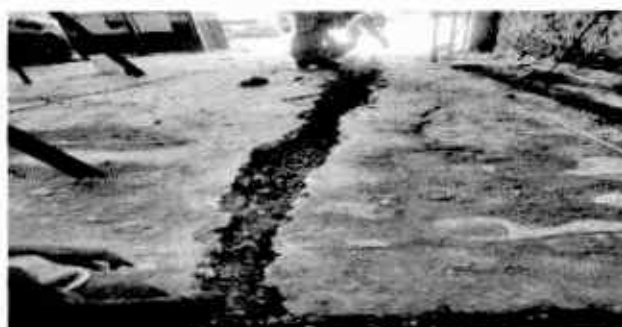
Foto 6: Sustitución de cuneta de concreto.
