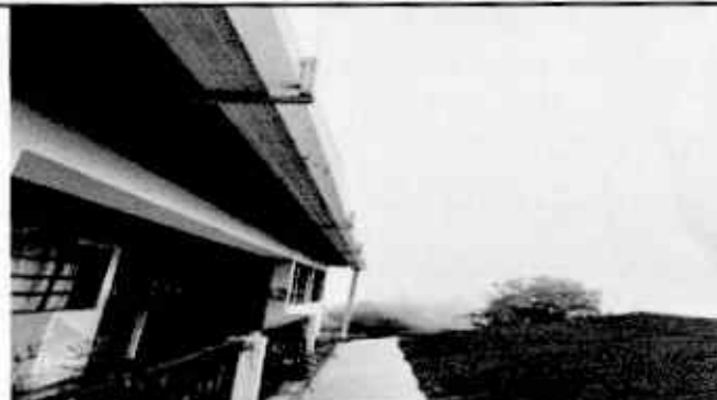
Foto 2: Sustitución de canal de metal.
