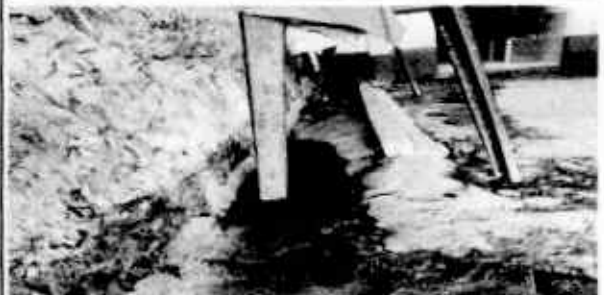
Foto 6: Sustitución de cuneta de concreto.
