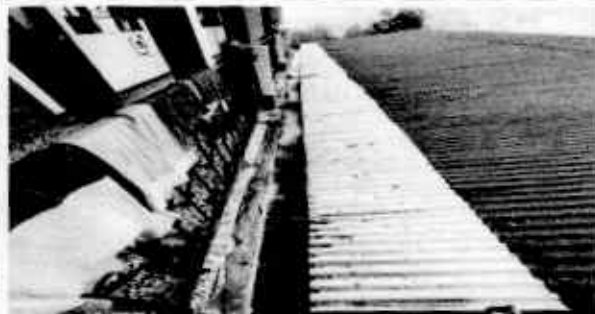
Foto 4: Sustitución de cuneta de concreto por canal de metal
