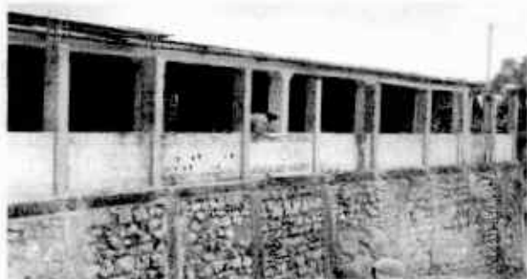
Foto 1: Repello de muros
