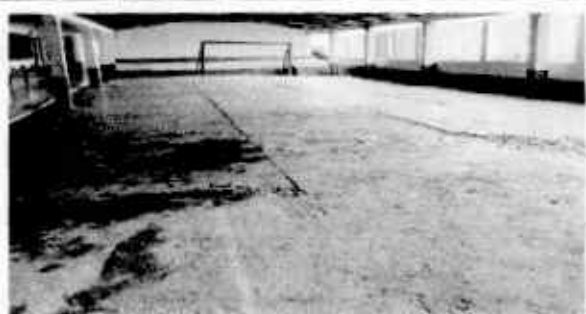
Foto 3: Reparación de plancha de concreto de patio.
