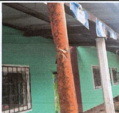
Foto 3: Reparación de caída de agua pluvial, debido a que ya se encuentra en muy mal estado.
