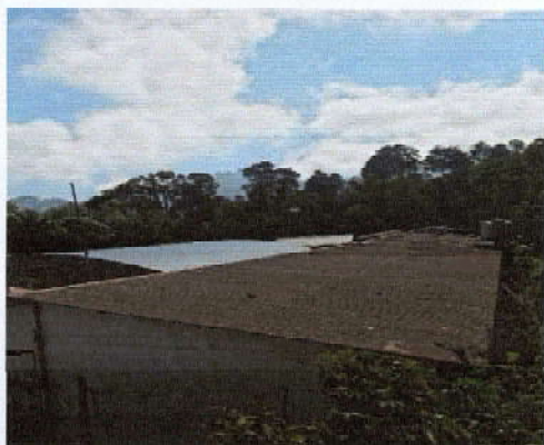
Foto 1: Se realizará sustitución de lámina por lámina troquelada aluzinc calibre 26, debido a que en invierno caen muchas goteras sobre los escritorios y muebles del aula.
