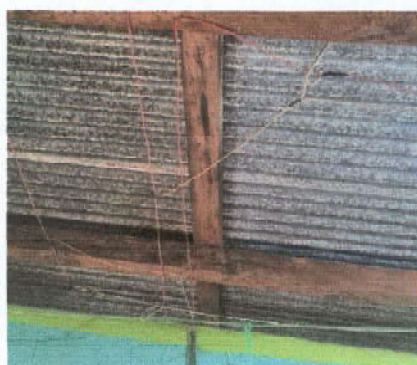
Foto 4: Sustitución de cableado eléctrico, porque se cuenta con el riesgo de que un corto circuito provoque un incendio.
