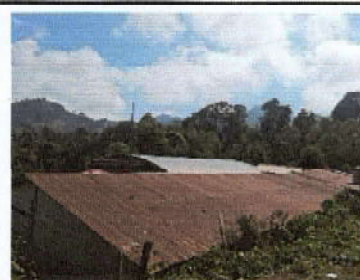
Foto 6: Se realizará la reparación del canal del techado, para evitar salpicaduras de agua en el invierno y que las paredes se humedezcan.
