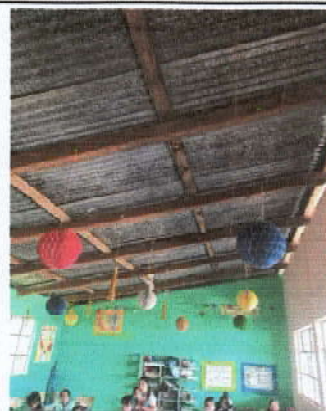
Foto 2: Se realizará sustitución de estructura de madera, por metal.
