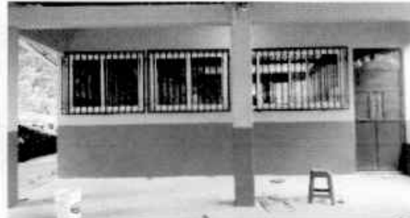
Foto 6: Renglón 6. PINTURA EN MUROS EXTERIORES E INTERIORES; Pintura en muros exteriores e interiores
