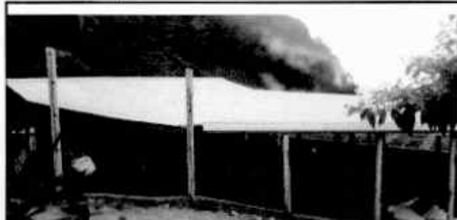
Foto 2: Renglón 2. CUBIERTA DE LAMINA; 1.2 Sustitución de capote de lamina para lamina troquelada
