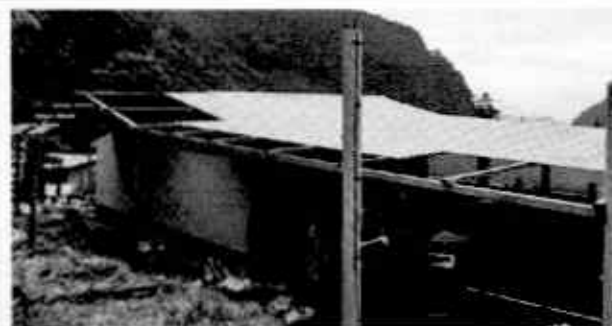
Foto 2: Renglón 2 .CUBIERTA DE LAMINA; 1.2 Sustitución de capote de lamina para lamina troquelada
