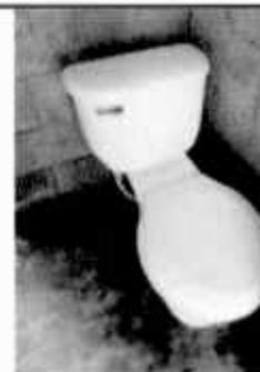
Foto 4: Renglón 4 . SERVICIOS SANITARIOS Y SUS ACCESORIOS; Sustitución de inodoros, Sustitución de lavamanos
