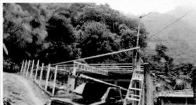
Foto 1: Renglón 1 . ESTRUCTURA DE TECHO; 1.1 Sustitución de lamina, por lamina troquelada aluzinc calibre 26
