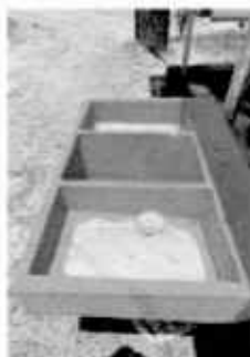
Foto 5: Renglón 5 . Sustitución de pila de cemento de dos lavaderos
