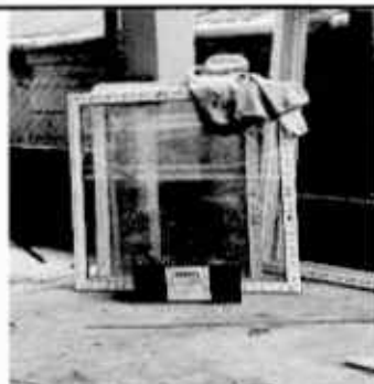
Foto 3: Renglón 3 . VENTANAS, Sustitución de estructura de metal de ventana por ventanas de PVC; Sustitución de balcones de metal; Sustitución de estructura de soporte de metal, por metal
