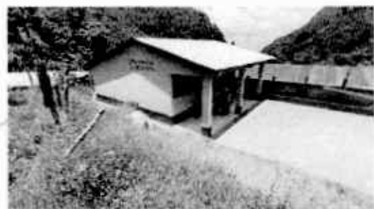
Foto 2: Renglón 2 .CUBIERTA DE LAMINA; 1.2 Sustitución de capote de lámina para lámina troquelada
