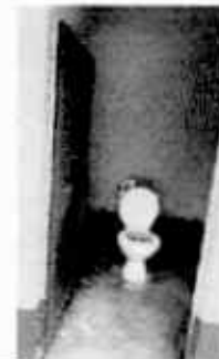
Foto 4: Renglón 4 . SERVICIOS SANITARIOS Y SUS ACCESORIOS; Sustitución de inodoros, Sustitución de lavamanos
