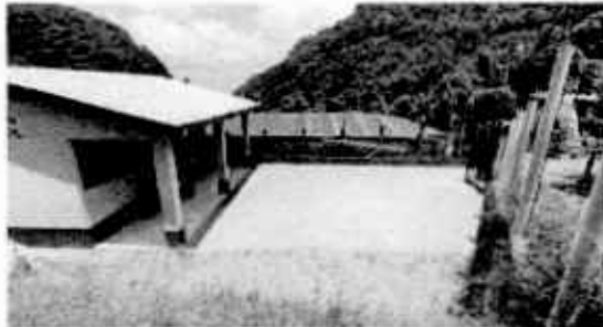
Foto1: Renglón 1 . ESTRUCTURA DE TECHO; 1.1 Sustitución de lámina, por lámina troquelada aluzinc calibre 26
