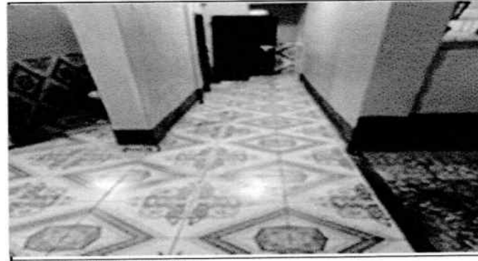
otra parte del baño finalizado
