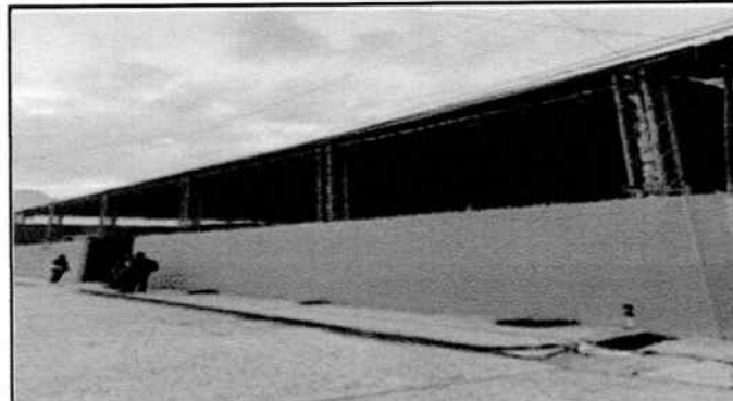
parte de puro exterior finalizado
