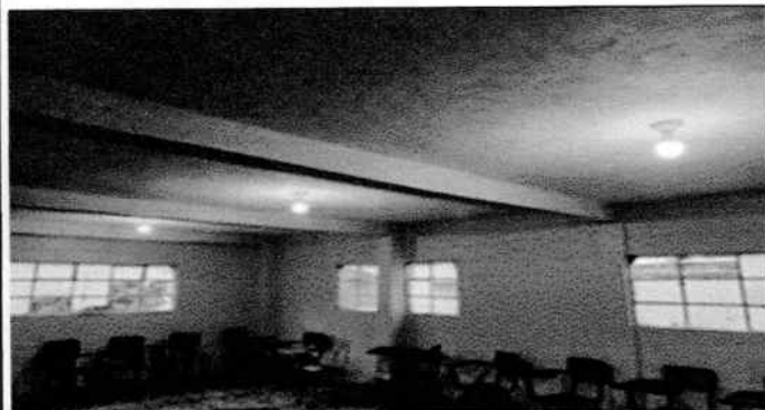
aulas terminadas de pintura
