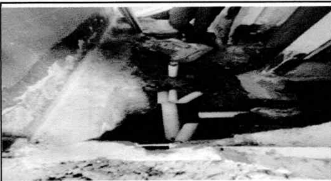
haciendo la instalación de tubería en los baños
