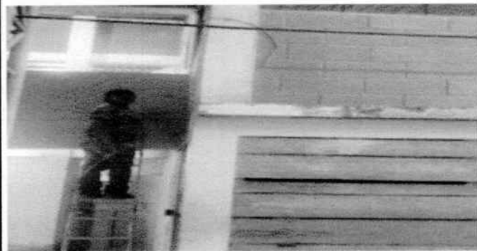
pintando muros exteriores
