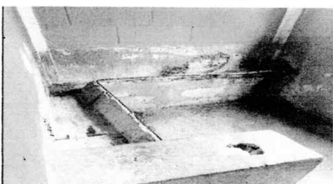
Sustitución de mingitorio
