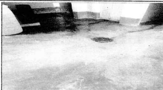
Sustitución de piso de granito
