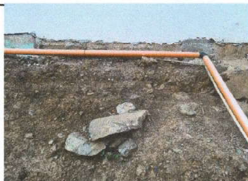
FOTO 6 Sustitución de drenaje
