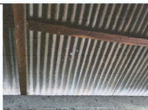
FOTO 12 Sustitución de lámina por lámina Aluzinc calibre 26
