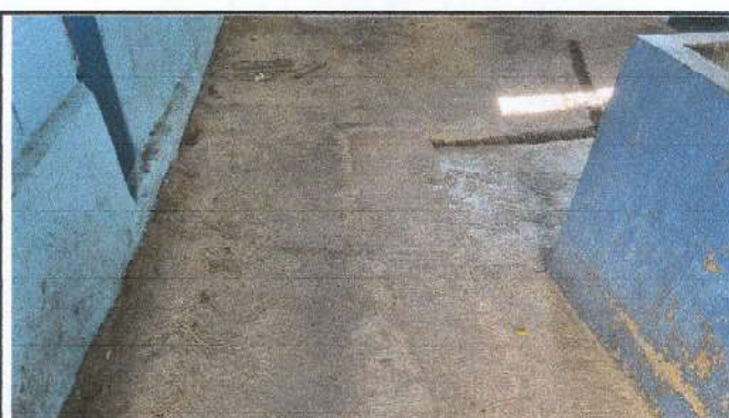
FOTO 4 Reparación de piso de concreto de baños
