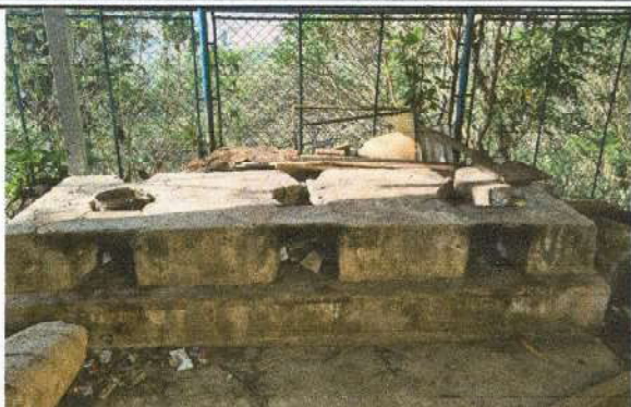
FOTO 1 Reparación de fogón de cocina
