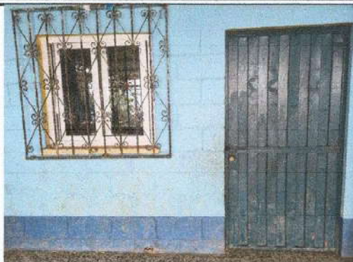
FOTO 14 Sustitución de puertas y balcones
