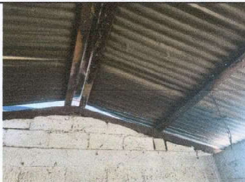
FOTO 13 Sustitución de estructura de madera por metal
