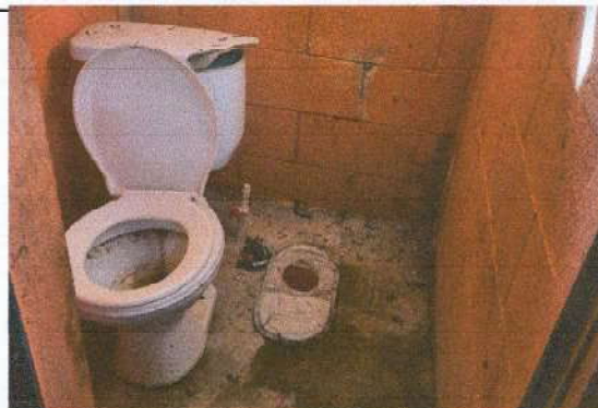
FOTO 10 Sustitución de Inodoro
