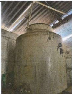
FOTO 7 Sustitución de depósito de agua
