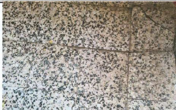
FOTO 2 Sustitución de piso por piso de granito de los baños
