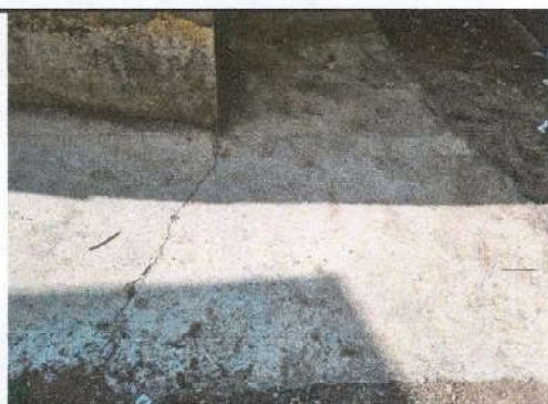
FOTO 5 Reparación de patio de la entrada de la cocina
