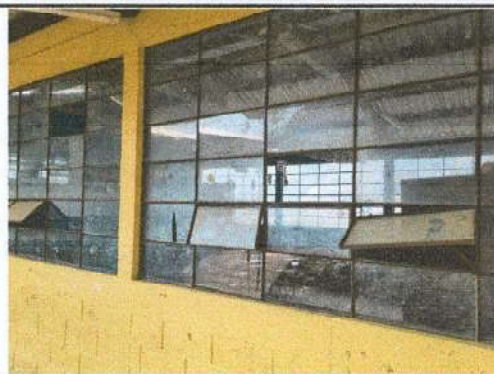
FOTO 8 Sustitución de vidrios fijos en ventana
