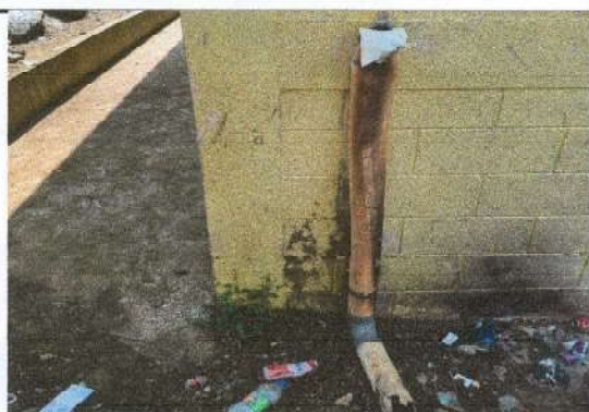
FOTO 3 Reparación de bajada de agua pluvial
