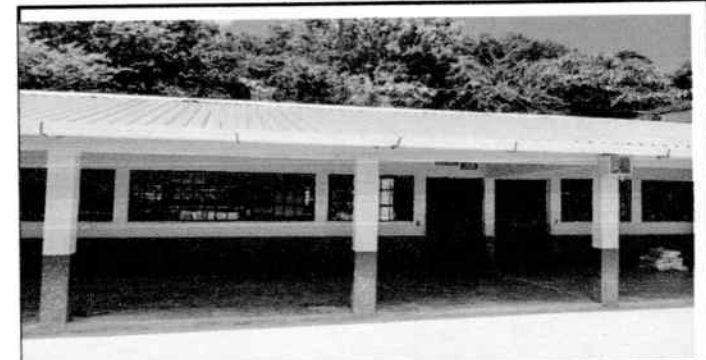
Foto 6: Torta de cemento y canales de agua pluvial
