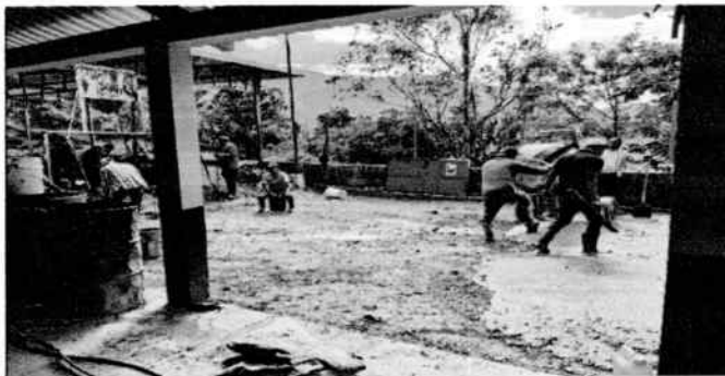
Foto 5: Sustitución de torta de cemento
