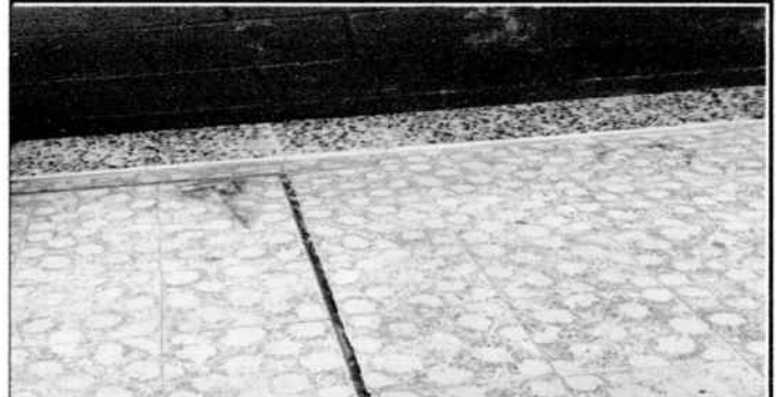
Foto 2: Colocación de piso de granito
