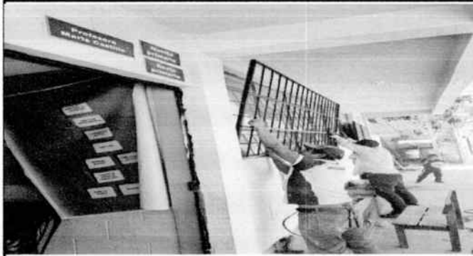
Foto 1: Colocación de Balcones
