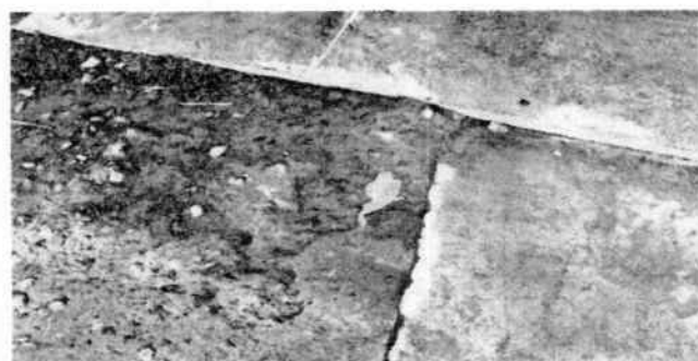
Foto 5: Sustitución de plancha de concreto
