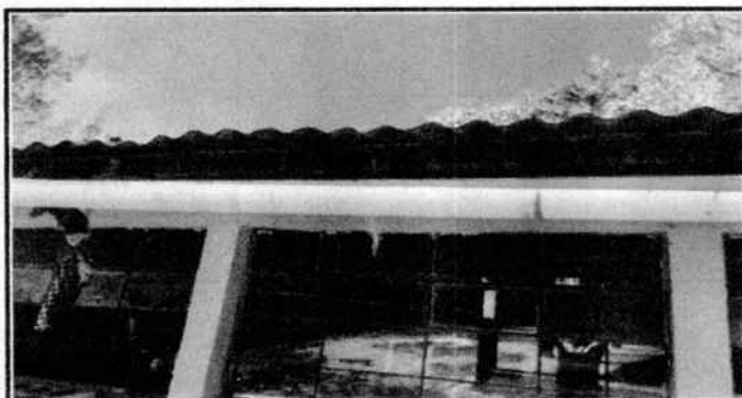
Foto 3: Sustitución de canales de agua pluvial
