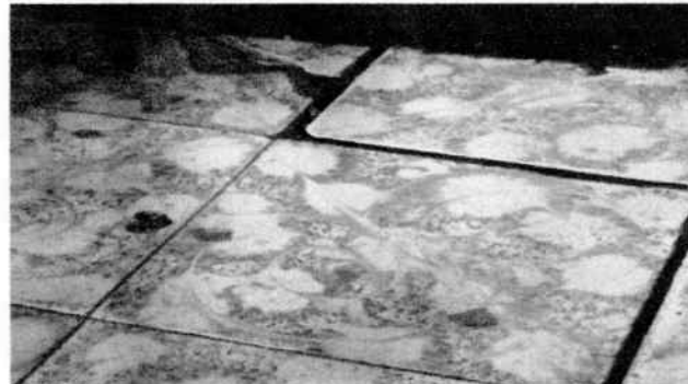
Foto 2: Sustitución de piso por piso
