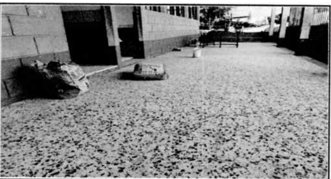
Foto 5: Puesta de piso en aulas
