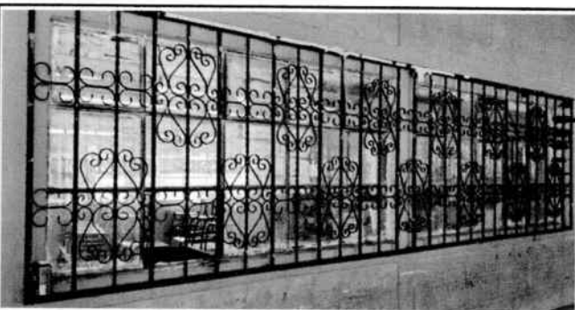
Foto 6: Mejoramiento de Balcones
