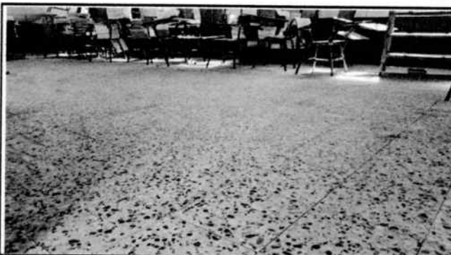
Foto 4: Puesta de piso granito
