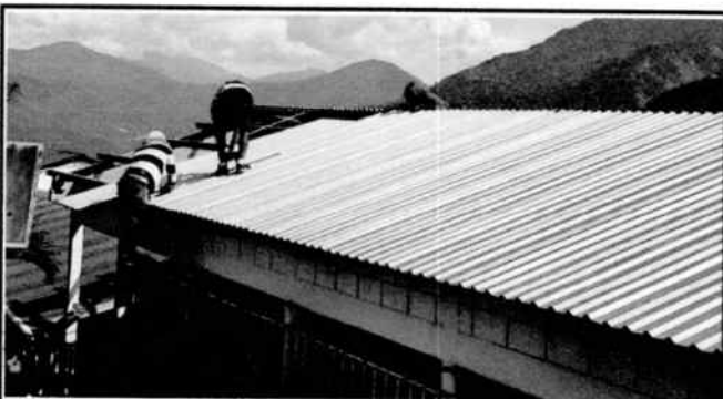
Foto 3: Sustitución lámina
