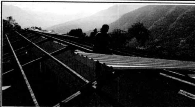
Foto 1: Sustitución de lámina EN MÓDULO 1.
