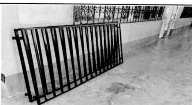
Foto 6: Mejoramiento de Balcones
