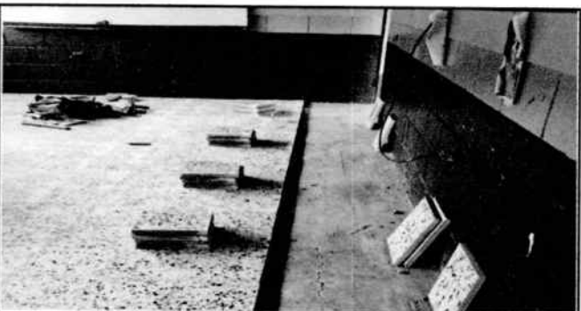
Foto 5: Puesta de piso en aulas
