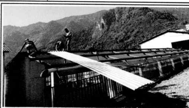
Foto 2: Sustitución de lámina en MÓDULO 2.
