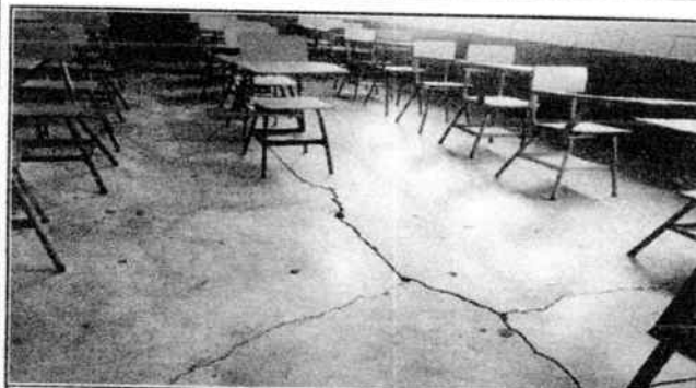
Foto 3: Sustitución de piso de cemento a piso de granito en 2 aulas.
