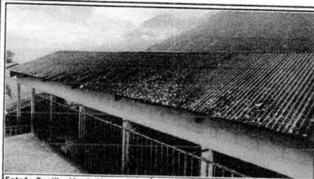
Foto 1: Sustitución de lámina EN MÓDULO 1.
