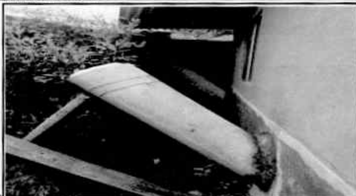
Foto 1: Terminación de chimeneas de cemento en la cocina
