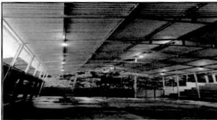
Foto 3: Así quedó el techado de cancha polideportiva.
