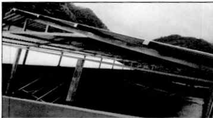
Foto 4: Finalización de techado de cancha polideportiva.
