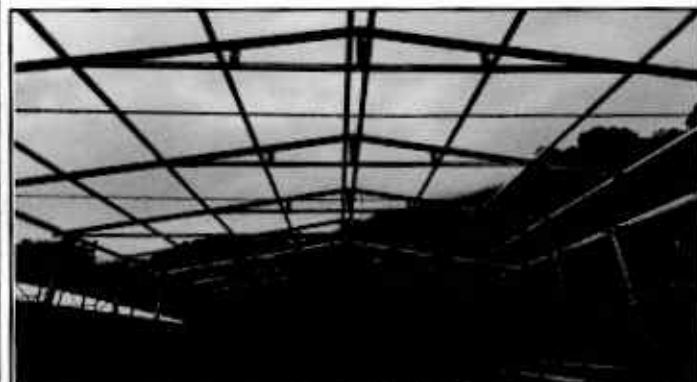
Foto 3: Soldadura de costaneras para techo de cancha polideportiva
