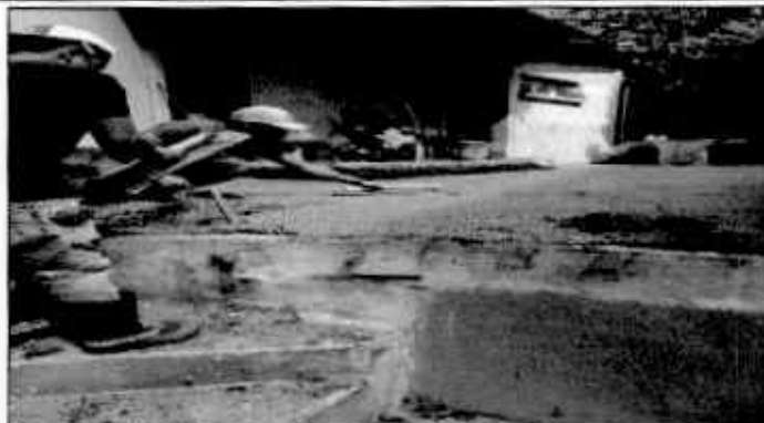
Foto 2: Realización de losa de patio.
