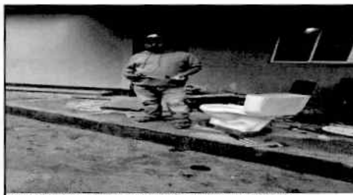
Foto 6: El albañil se está armando el baño para su instalación.
