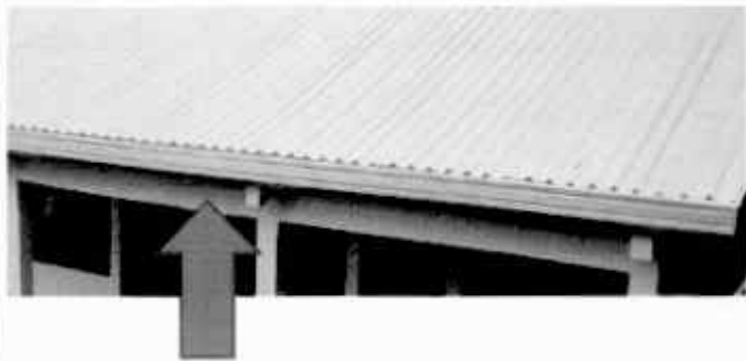
Foto 3: Renglón 3. 3.1 CANALES Y BAJADA DE AGUA PLUVIAL; Sustitucion de canal de metal
