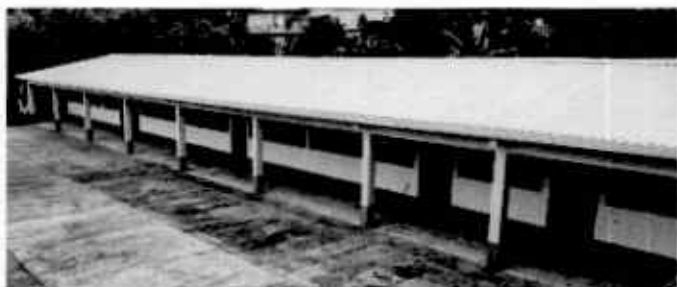
Foto 5: Renglón 1. 1.2 Sustitucion de capote de lamina para lamina troquelada
