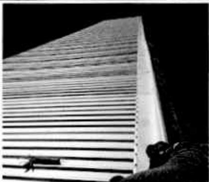
Foto1: Renglón 1. CUBIERTA DE LAMINA; 1.1 Susutitucion de lamina, por lamina troquelada aluzinc calibre 26
