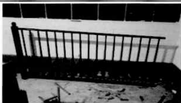
Foto 5: Renglón 4. MANTENIMIENTO A BARANDAS; Sustitucion de barandas de metal
