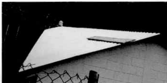
Foto1: Renglón 1. CUBIERTA DE LAMINA; 1.1 Susutitucion de lamina, por lamina troquelada aluzinc calibre 26
