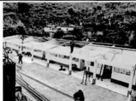
Foto 2: Renglón 2. 2.1 Susutitucion de estructura de soporte de metal, por metal
