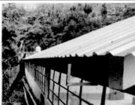
Foto 3: Renglón 3. 3.1 CANALES Y BAJADA DE AGUA PLUVIAL; Sustitucion de canal de metal
