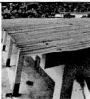
Foto 3: Renglón 3. 3.1 CANALES Y BAJADA DE AGUA PLUVIAL; Mejoramiento de canal de metal
