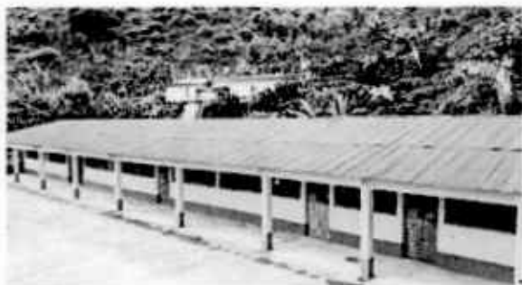
Foto 1: Renglón 1. CUBIERTA DE LAMINA; 1.1 Sustitución de lámina, por lámina troquelada aluzinc calibre 26
