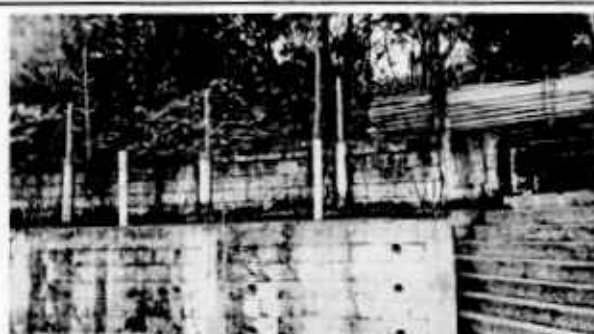
Foto 5: Renglón 4. MANTENIMIENTO A BARANDAS; Mejoramiento de barandas de metal para gradas.
