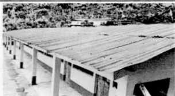
Foto 5: Renglón 1. 1.2 Sustitución de capote de lámina para lámina troquelada
