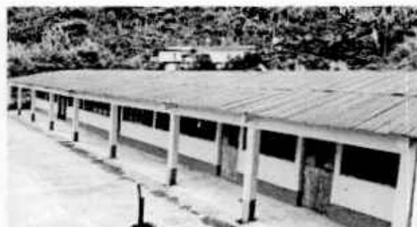
Foto 4: Renglón 3. 3.2 Mejoramiento de bajada de agua pluvial con tubo pvc 3"
