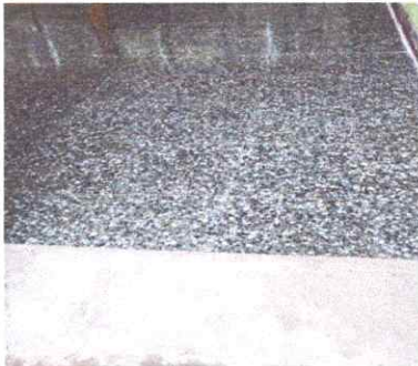
Foto1: Sustrución de piso por piso de granito
