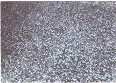
Foto 2: Sustrución de piso por piso de granito
