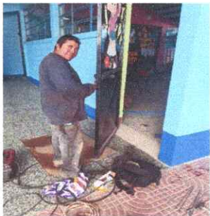
Foto 6: Sustituir candados de puertas a cerraduras Yale.
