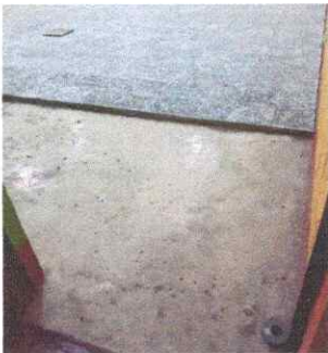
Foto1: Sustitución de piso por piso de granito
