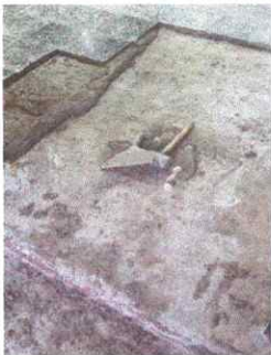
Foto 2: Sustitución de piso por piso de granito
