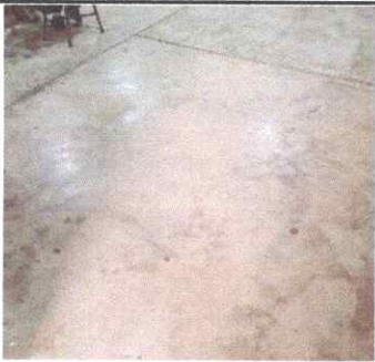
Foto1: Sustrucción de piso por piso de granito
