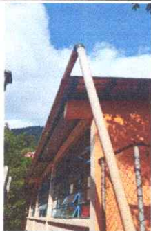
Foto 4: Foto 3: Colocar y cambiar canales de caidas de aguas pluviales.
