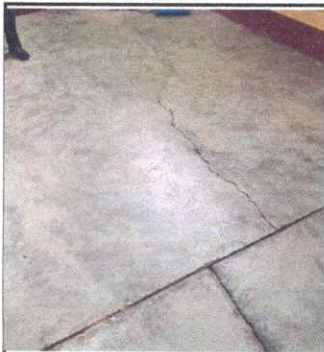
Foto 2: Sustrucción de piso por piso de granito
