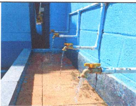
Chorros ya instalados
