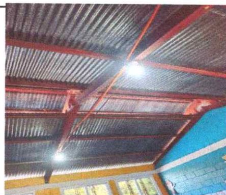
Instalacion de luz concluida
