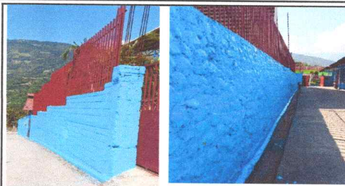
Muro perimetral ya pintado
