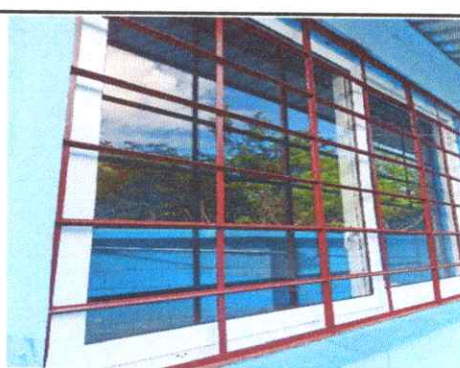
Balcones ya instalados
