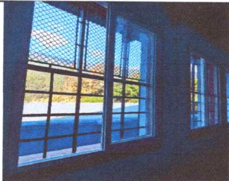
Ventana de UPVC terminada e instalada
