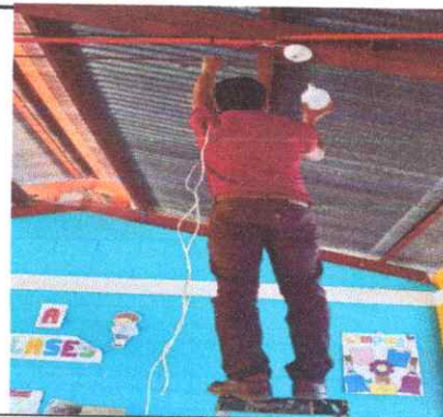
Trabajando la instalación eléctrica
