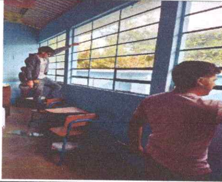
Trabajando la estructura de metal de ventana, por ventana de UPVC blanco
