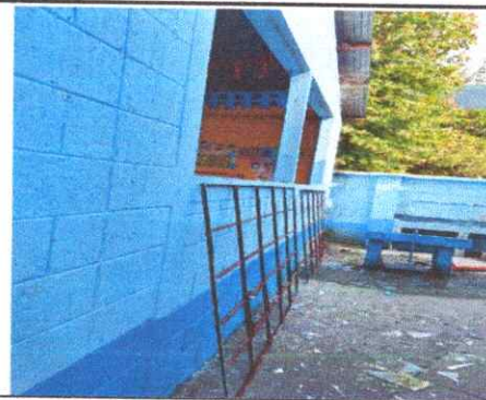
A colocar los balcones de metal
