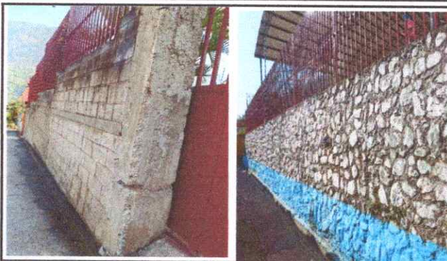
Muro perimetral a pintar
