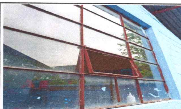
Sustitucion de balcones de metal
