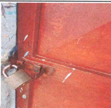
Sustitucion de chapa de metal
