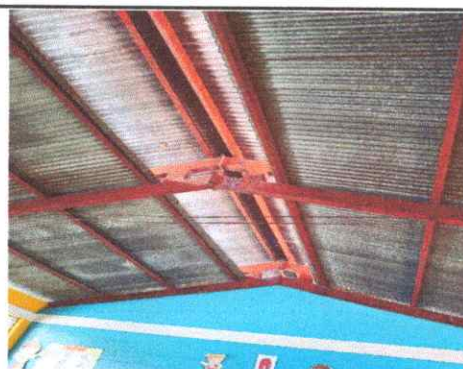
Reparacion de cableado electrico
