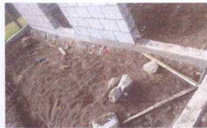
Foto 6: Mejoramiento con puertas y ventanas
