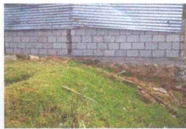
Foto 2: repello en paredes
