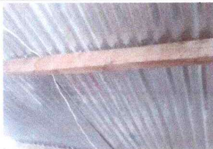
Foto 3: Sustitucion de techo por lamina alizinc calibre 26
