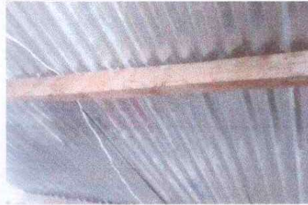
Foto 4: Sustitución de estructura de madera por metal, costaneras
