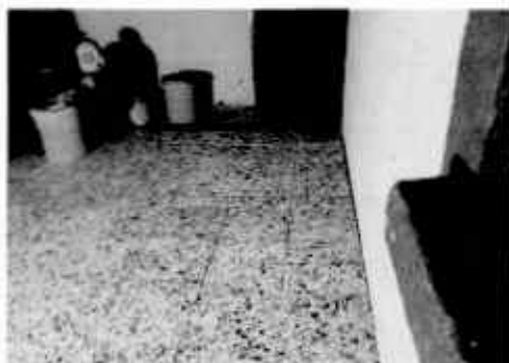
Foto 3: Renglón 2. Sustitución de torta de cemento, por piso granito
