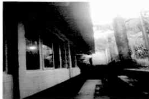
Foto 2: Renglón 1. Sustitución de ventanas de metal
