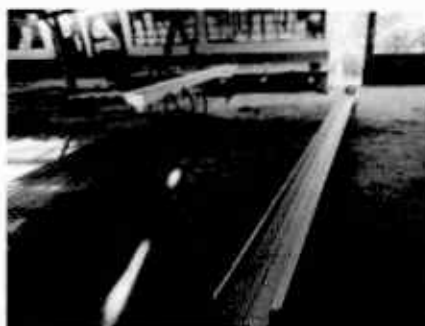
Foto 9: Renglón 9. Mejoramiento de canal de metal
