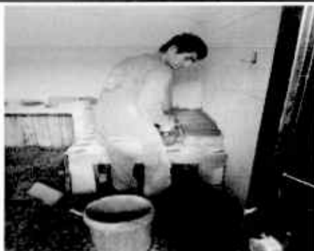
Foto 7: Renglón 6. Sustitución de estufa rural (completa) incluye chimenea y plancha de metal
