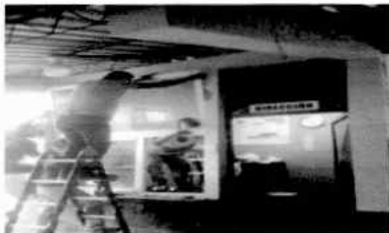
Foto 1: Renglón 1. Sustitución de ventanas de metal
