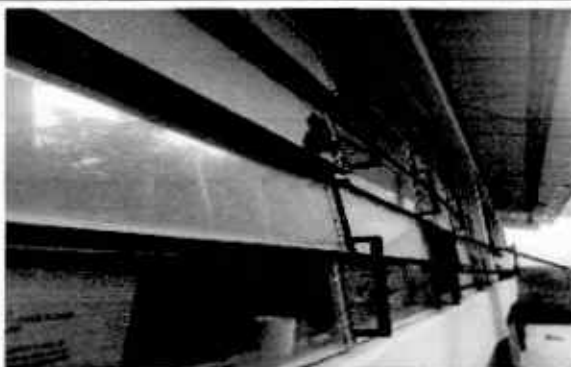
Foto 1: Renglón 1. Sustitución de ventanas de metal
