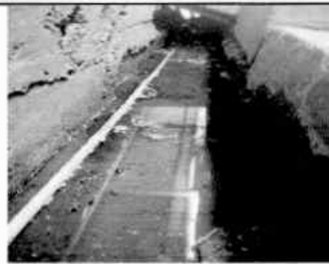
Foto 8: Renglón 7. Reparación de cuneta de concreto con soporte de electromalla
