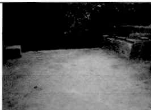
Foto 3: Renglón 2. Sustitución de torta de cemento, por piso granito
