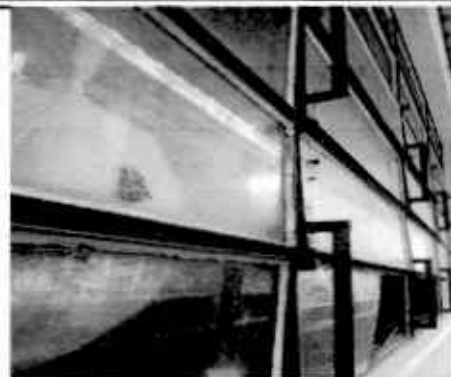
Foto 2: Renglón 1. Sustitución de ventanas de metal
