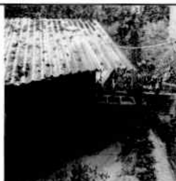
Foto 4: Renglón 3. Sustitución de techo, por lámina troquelada
