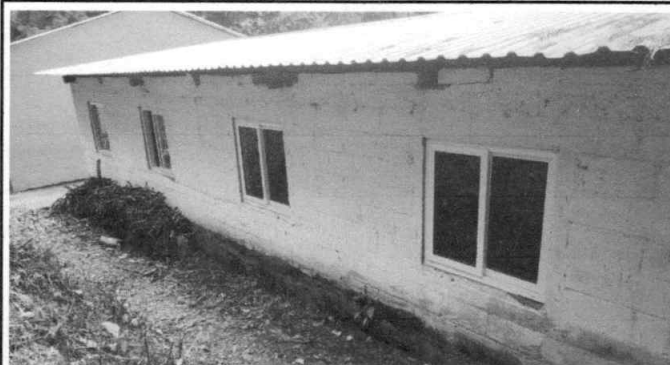
Foto 4: SUSTITUCION DE VENTANAS
