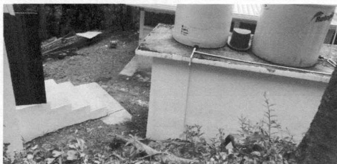
Foto 1: repello en baños
