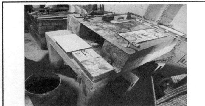
Foto 5: Reparacion de estufa rural
