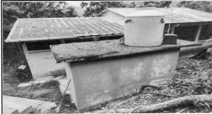
Foto 1: repello en baños
