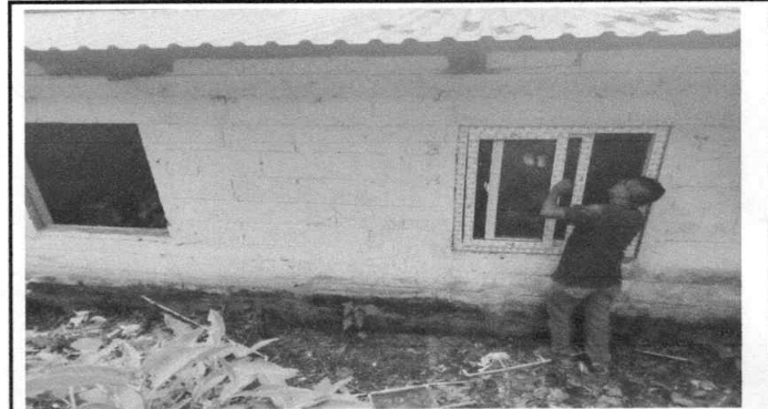
Foto 4: SUSTITUCION DE VENTANAS
