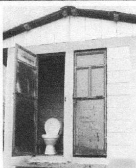
Foto 3: Sustitucion de puertas de sanitarios
