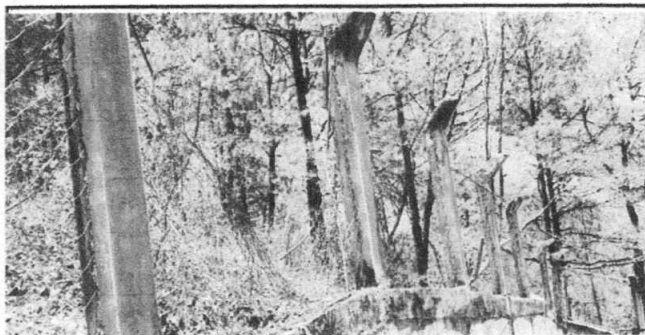
Foto 6: Reparacion de malla
