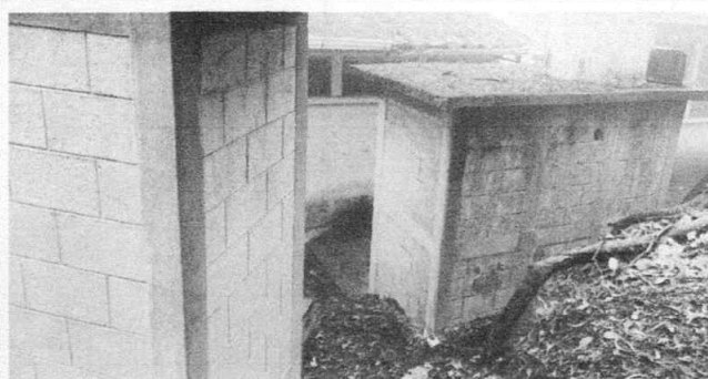
Foto1: repello en baños
