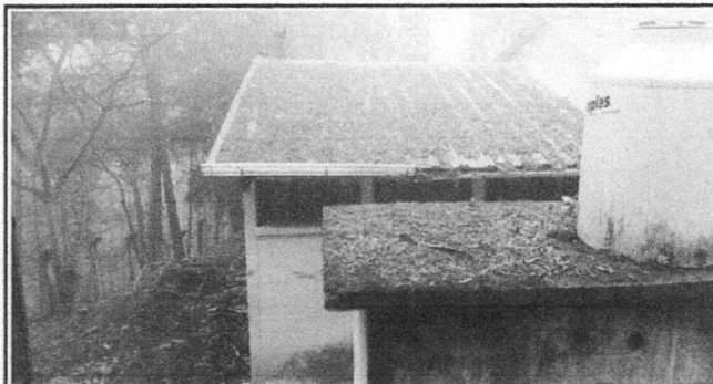
Foto 2: sustitucion de lamina en cocina
