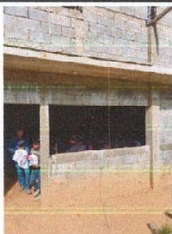
Foto1: mejoramiento puerta de metal
