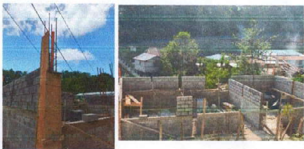
Foto 8: Mejoramiento de elementos de Fijación
