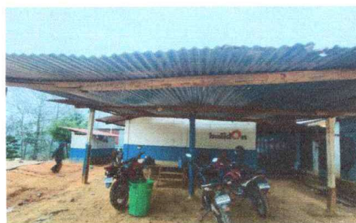
Foto 4: Cambio de estructura metálica y techado
