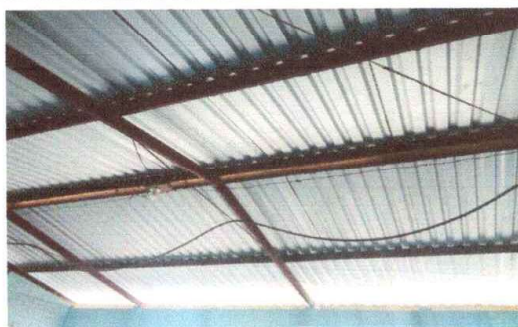
Foto 6: Cambio de techo
