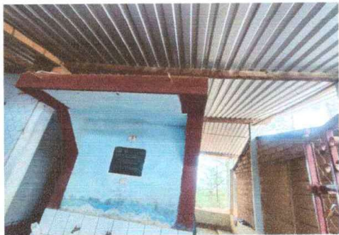
Foto1: Cambio de estructura de techado
