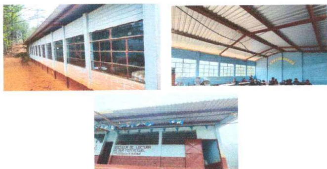
Foto 3: Pintura en las paredes adentro y afuera
