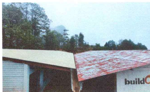
Foto 2: Cambio de canales para bajada de agua pluvial
