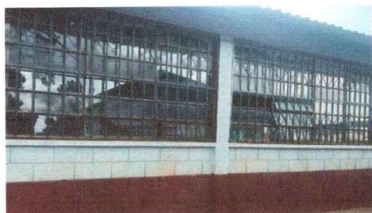
Foto 5: Cambio de vidrios
