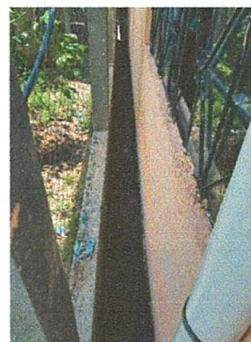
Foto 4: Mejoramiento de cuneta con concreto
