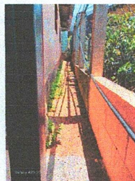
Foto 4: Mejoramiento de cuneta con concreto
