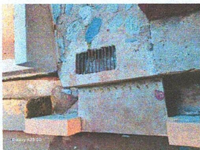
Foto 3: reparacion de cuneta
