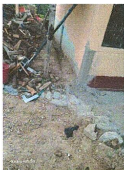
Foto 3: reparacion de cuneta
