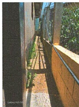
Foto 4: Mejoramiento de cuneta para la aplicación de concreto
