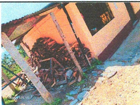
Foto 5: reparación de banqueta de concreto
