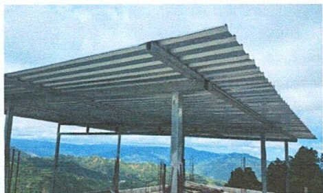
Foto 3: cubierta de lámina en rampa
