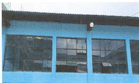
Foto 5: vidrios nuevos instalados
