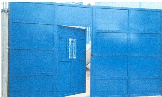
Foto 7: Portón principal nuevo
