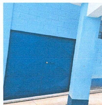
Foto 8: Reparacion de portón
