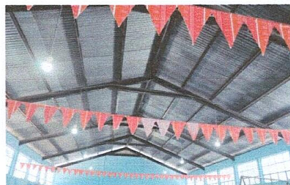
Foto 6: Sistema eléctrico reparado
