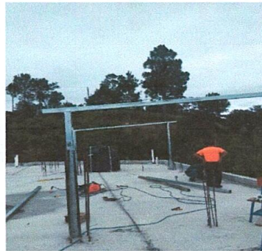
Foto 2: Instalando soporte para proteger rotoplas
