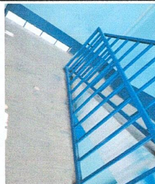
Foto 10: Aplicación de pintura en barandas
