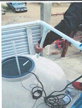
Foto 11: Instalación de tubería en rotoplas
