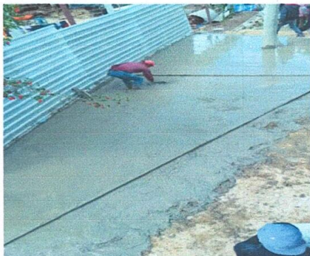
Foto1: Cementado de losa en patio
