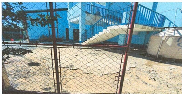
Foto1: Reparación de losa de concreto en patio
