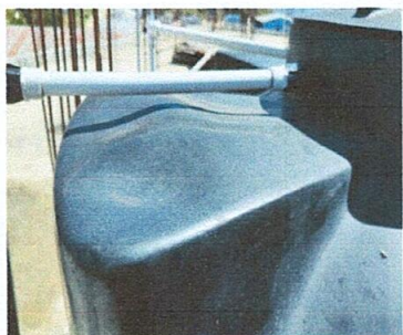
Foto 9: Rotoplas en mal estado
