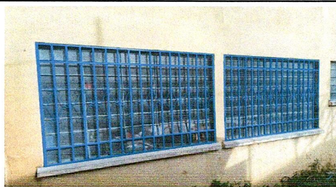
Foto 2: 6.1 Sustitución de balcones de metal
