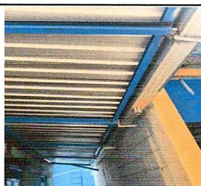
Foto 6: 1. Sustitución de lámina, por lámina troquelada aluzinc calibre 26
