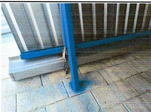
Foto 3: 9.1 Sustitución de techo de lámina por lámina troquelada
