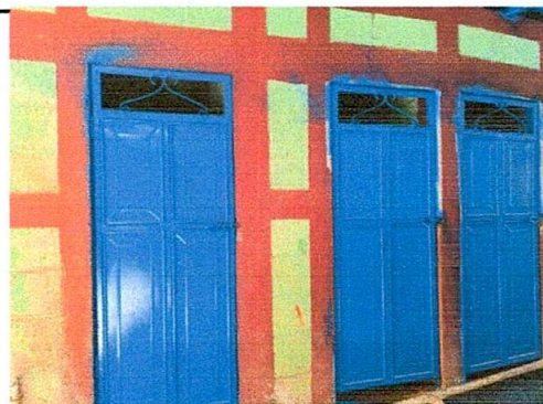
Foto 4: 10.1 Aplicación de pintura a puertas servivos sanitarios
