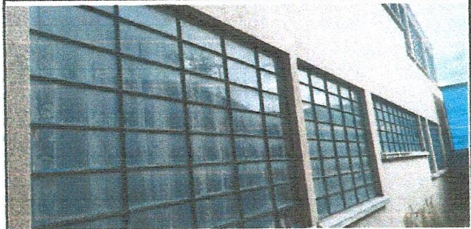
Foto 2: 6.1. Mejoramiento de ventanas
