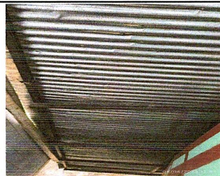
Foto 6: 1. Sustitución de lámina, por lámina troquelada aluzinc calibre 26
