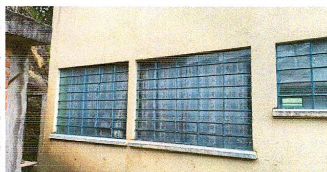
Foto 2: 6.1 Sustitución de balcones de metal
