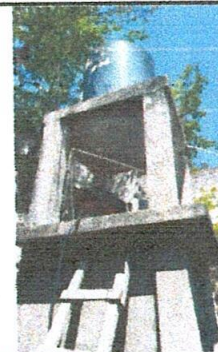
Foto 4: 17. Mantenimiento de cisternas para agua
