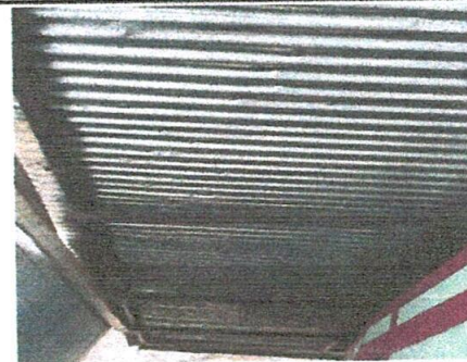
Foto 6: 6.1. Sustitución de canales en techo de lámina.
