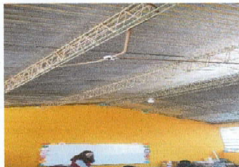
Foto 2: Sustrución hierro por costaneras
