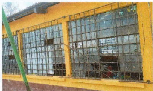
Foto 3: Sustrución de balcones y ventanas
