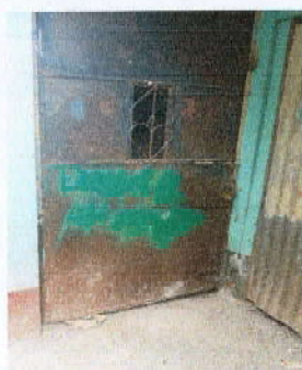
Foto 5: Sustrución de puertas
