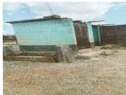
Foto 6: Mejoramiento de baños, cambio de techo y pintura
