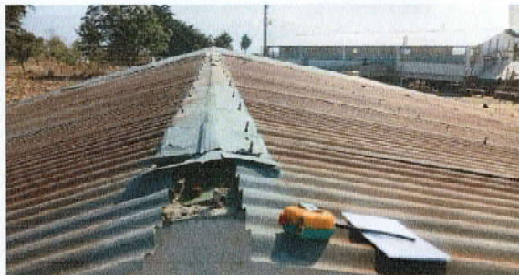
Foto 1: Sustrución de techo y capote
