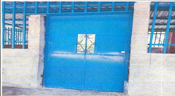
Foto7: Sustitución de puerta de madera por puerta de metal
