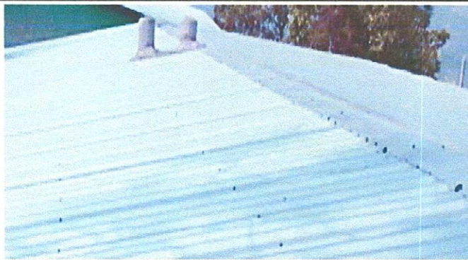
Foto 3: Sustrutución de capote de metal
