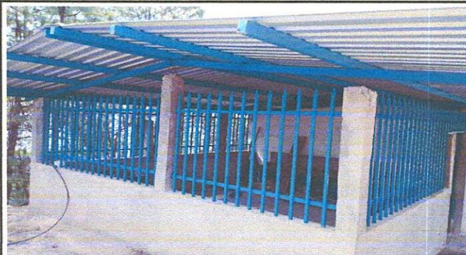
Foto 9: Sustitución de malla por barandas de metal
