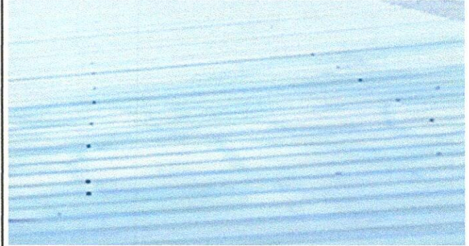
Foto 2: Sustrutución de elemento de fijación para lámina troquelada
