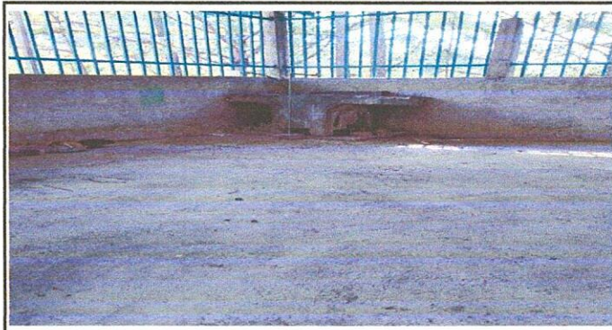
Foto 10: Sustitución de piso de concreto a piso de torta de concreto
