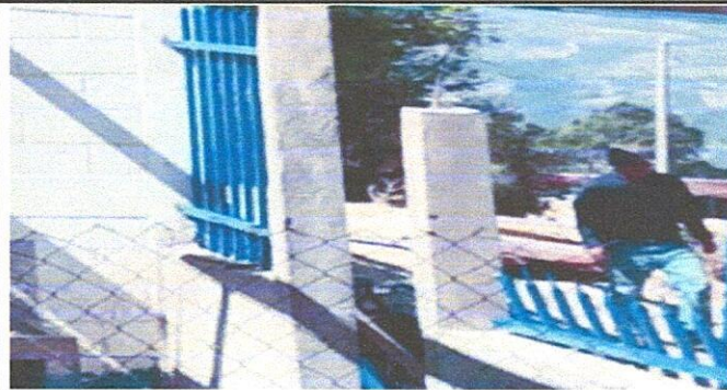
Foto 8: Sustitución de malla por barandas de metal
