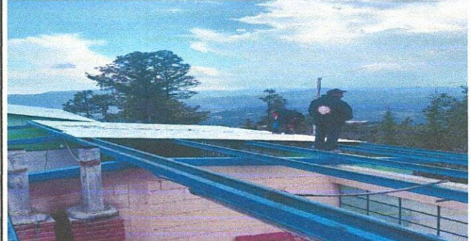
Foto 2: Sustitución de elemento de fijación para lámina troquelada
