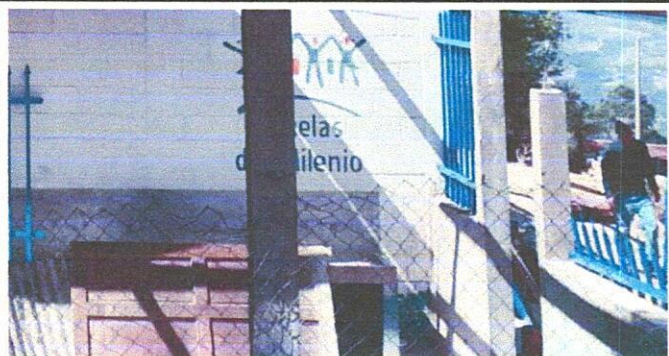
Foto7: Sustitución de puerta de madera por puerta de metal
