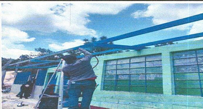
Foto 5: Mantenimiento a estructura de soporte de metal, lijado y aplicación de pintura
