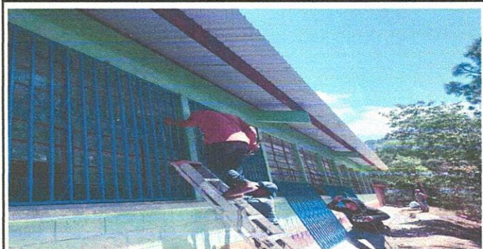
Foto 6: Sustitución de balcones de metal
