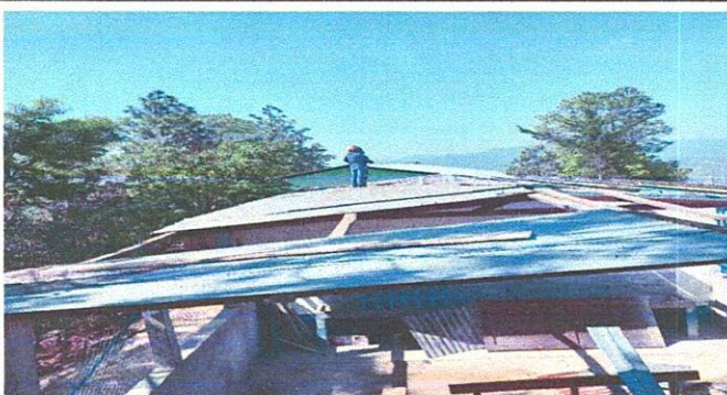
Foto 3: Sustitución de capote de metal
