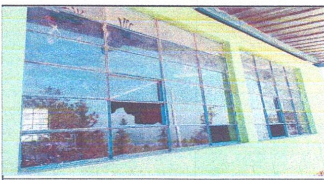
Foto 6: Sustrucción de balcones de metal
