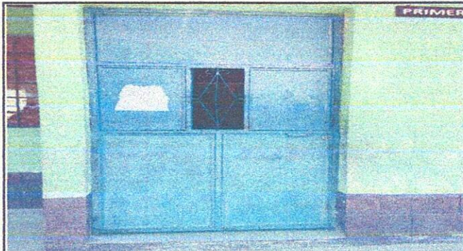
Foto 8: Mantenimiento a puerta de metal lijado y pintado
