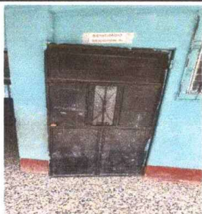
FOTO 7. MANTENIMIENTO A PUERTAS DE METAL, LIJADO Y PINTADO
