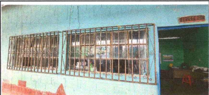
FOTO 5. MANTENIMIENTO A BALCONES DE METAL 1.20 mts de alto X 2.15 mts de ancho.
