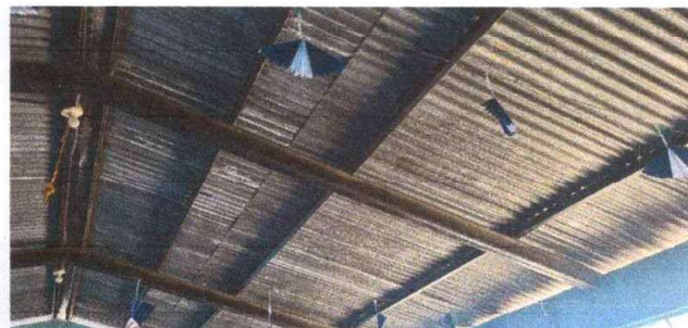
FOTO 2. MANTENIMIENTO A ESTRUCTURA DE SOPORTE DE METAL
