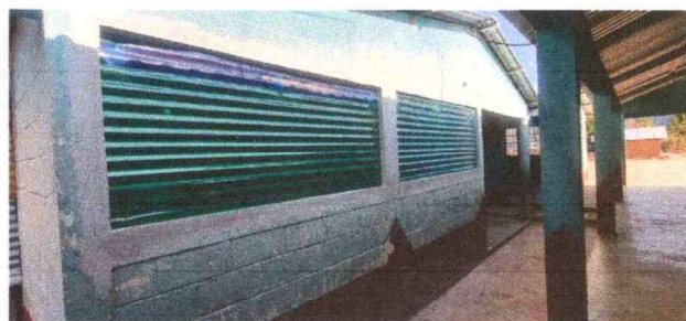
FOTO 4. SUSTITUCIÓN DE VENTA DE LÁMINA POR VENTANA DE METAL MÁS VIDRIO 1 mt alto X 2.29 mts ancho.
