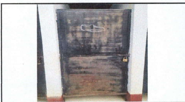
Foto 5: Mantenimiento de puerta de servicios sanitarios
