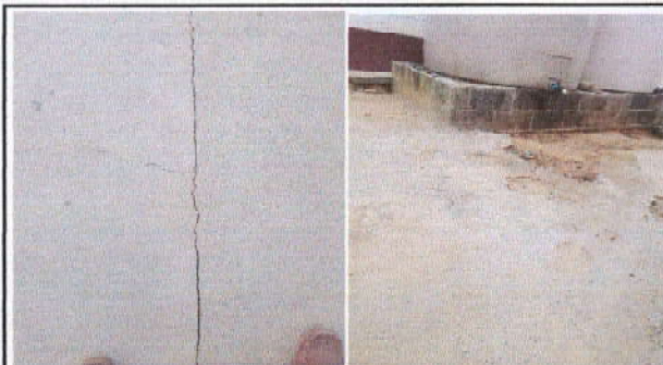
Foto 1: Sustitución de piso por piso de torta de concreto
