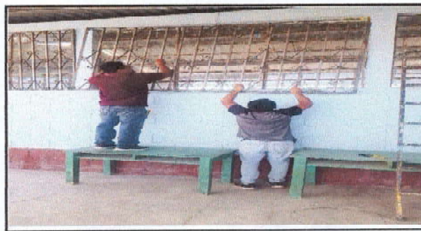
Foto 6: Sustitución de balcones de metal
