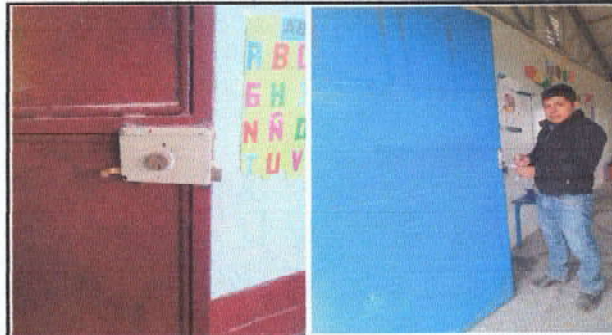
Foto 2: Sustitución de chapa Yale
