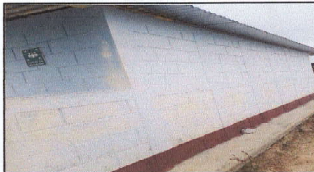
Foto 4: Pintura de servicios sanitarios
